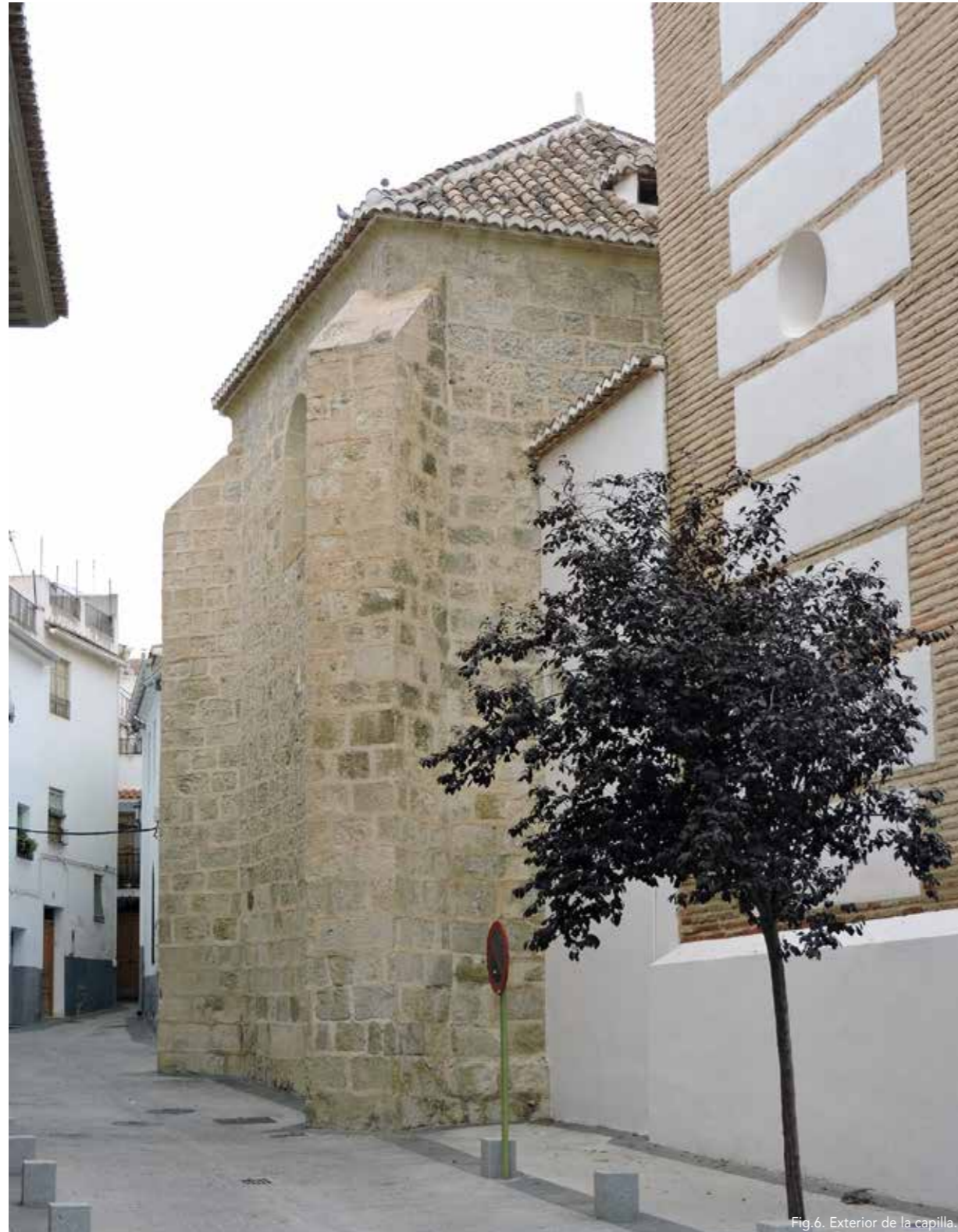
Fig.6. Exterior de la capilla.
