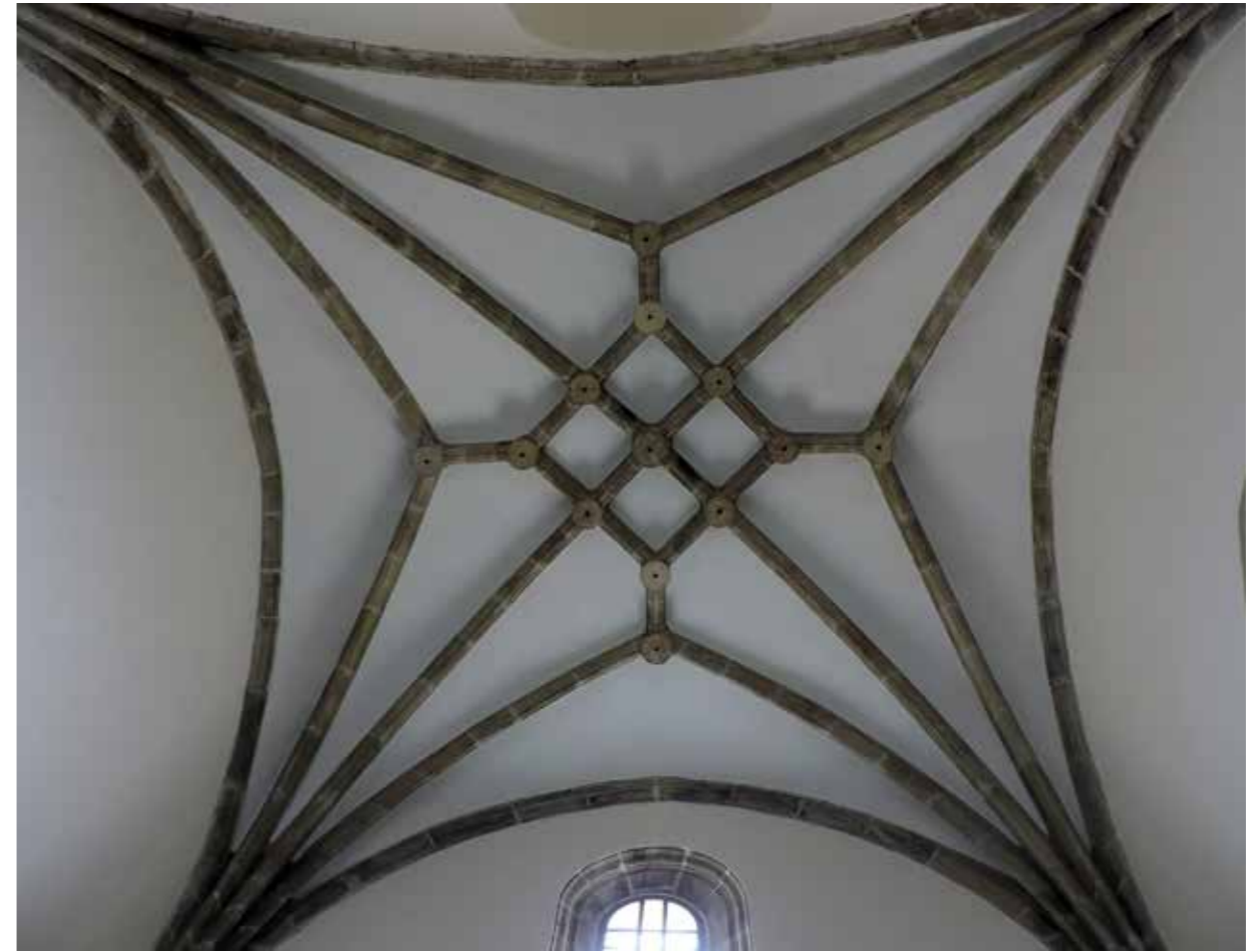
Fig.5. Bóveda de crucería.
