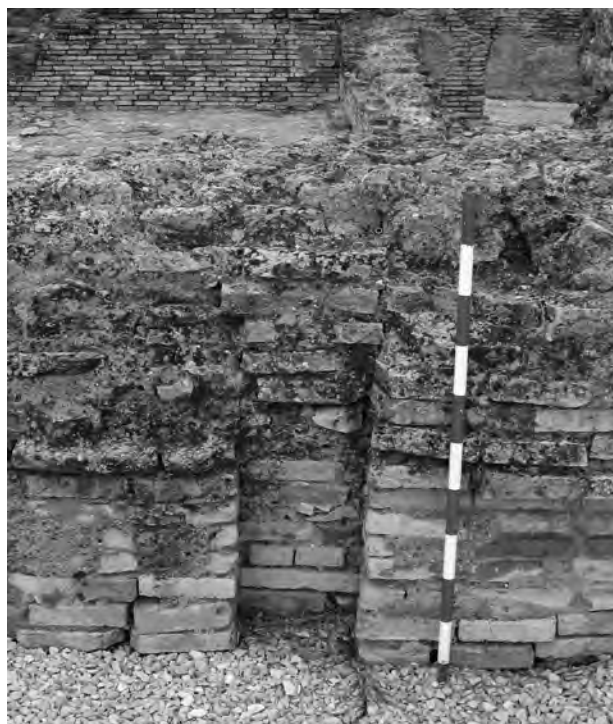
Fig. 13: Detalle del sistema de encofrado y de la construcción del muro en alzado (Espacio 4).
