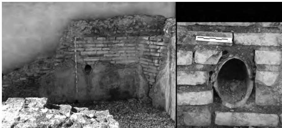
Fig. 20: Pasillo de servicio (Espacio 2 y 3) y detalle de los orificios circulares para el drenaje de agua.
