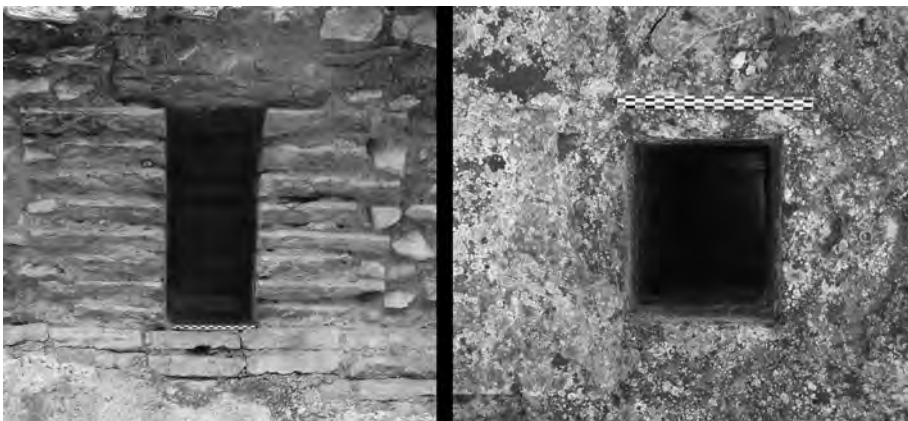
Fig. 16: Detalle del sumidero visto desde el interior y desde el exterior de la galería de servicio.
