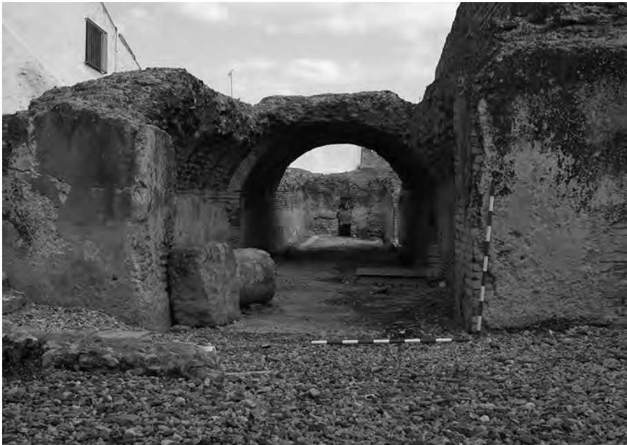
Fig. 15: Vista de la galería de servicio (Espacio 22).
