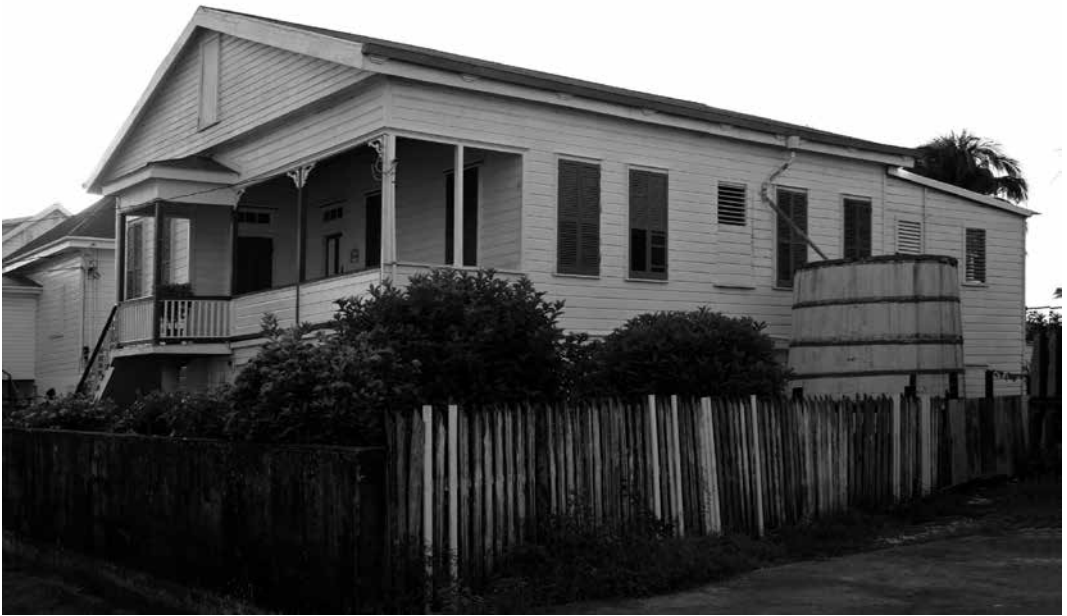
Figura 5. Casa en Cork Street en Belice City, se observa en primer término el curvato y su sistema de captación de las aguas pluviales
