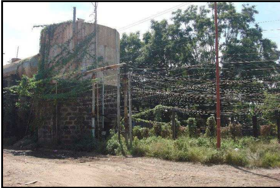
Imagen 6.2. Depósito de agua y cableado eléctrico.
